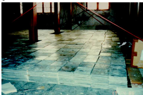
Aspecto de uma das câmaras da CBJ, vendo-se o piso de chumbo usinado e parte da estrutura de apoio.
